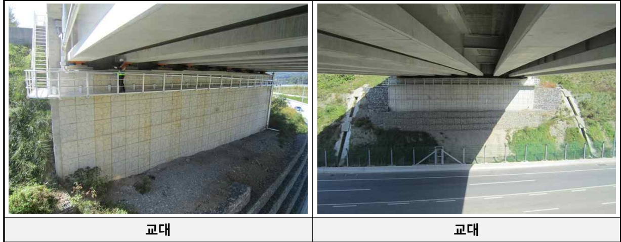
[교대 및 교각 전경]
